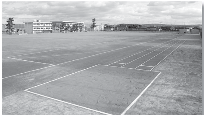
完成したグラウンド(奥に見えるのは高浜高校)
