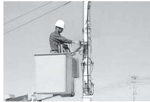
着々と架線工事が進められている ケーブルテレビ整備事業
