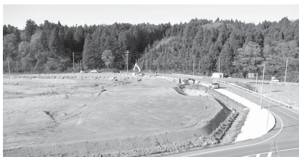
西山台ニュータウンの造成工事風景
