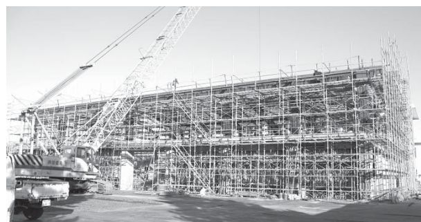
富来小学校体育館新築工事風景
