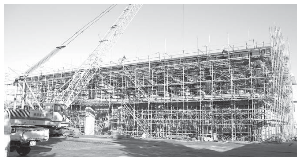
富来小学校体育館新築工事風景
