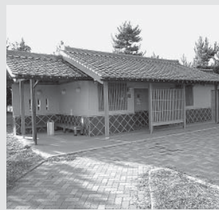
柴木総合公園整備（トイレ整備）
