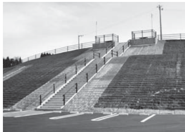
第2工区（正面階段）
