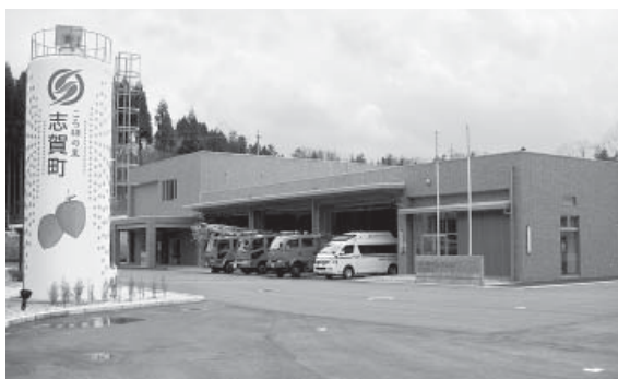
完成した志賀消防署新庁舎
