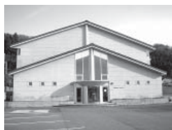
穂造スポーツセンター
