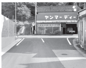
道路の拡幅整備
