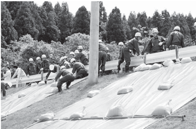
土砂崩れ防止のためシート張り訓練を行う消防団員
