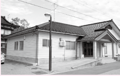
▲公民館への移行が検討された コミュニティセンター
