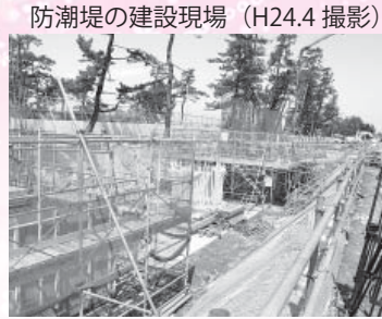
防潮堤の建設現場 (H24.4 撮影)
