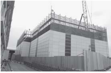
校舎棟新築工事
