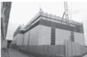
校舎棟新築工事
