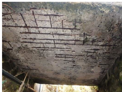
コンクリート橋の床版
