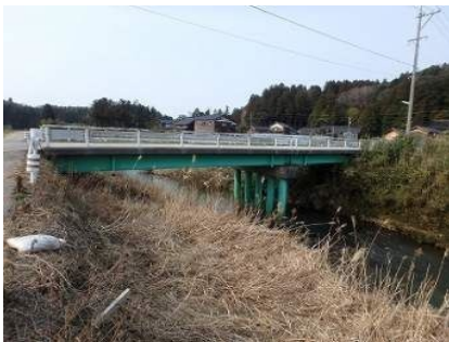
地の丸橋 橋長 26.1m 1973 年架設
