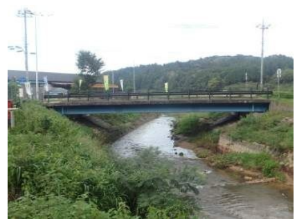
上棚出橋 橋長 22.0m 1969 年架設
