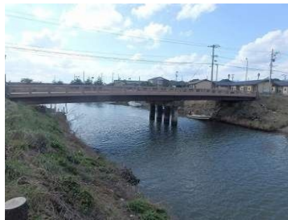
浜の橋 橋長 39.0m 1971 年架設
