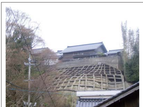
急傾斜地崩壊対策事業
