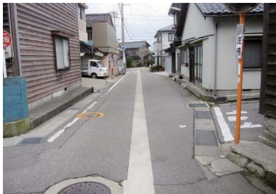
生活道路における融雪施設の整備
