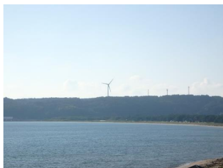
酒見風力発電所
