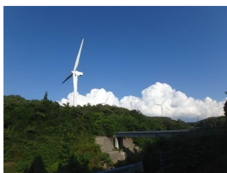
福浦風力発電所
