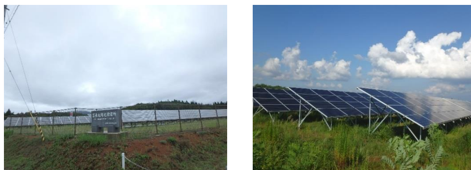
図 3-4 町における太陽光発電所（1,000kW以上）の主な導入事例
