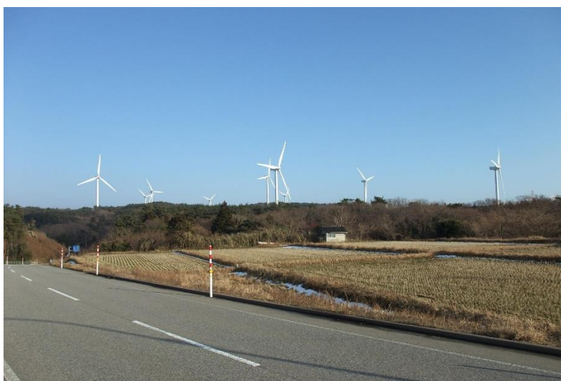
福浦風力発電所
