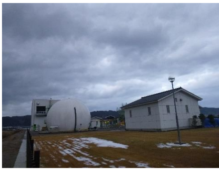
鹿島中部クリーンセンター
