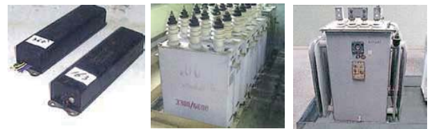
安定器 大型コンデンサー 大型変圧器(トランス)
