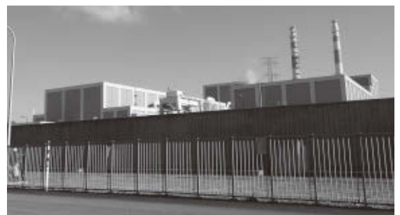
運転停止中の志賀原子力発電所
