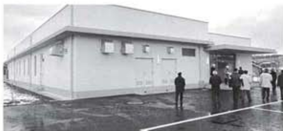
富来防災センターの内部(上)と外観(下)
