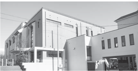
改修が行われた総合武道館
