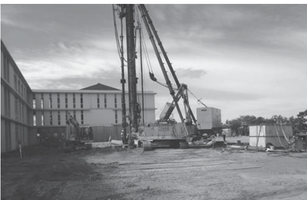
志賀小学校の工事現場（9月30日現在）
