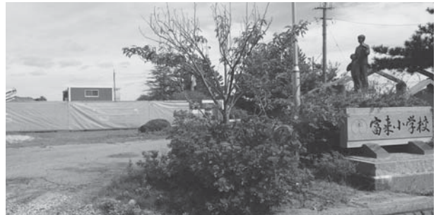
富来防災センター（仮称）の建設用地（9月30日現在）
