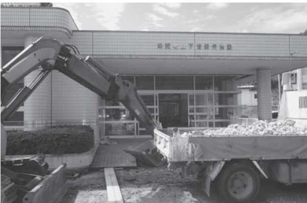
改修中の旧下甘田保育園（9月30日現在）
