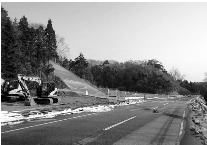
安全な工事を実施するために増工を行う
