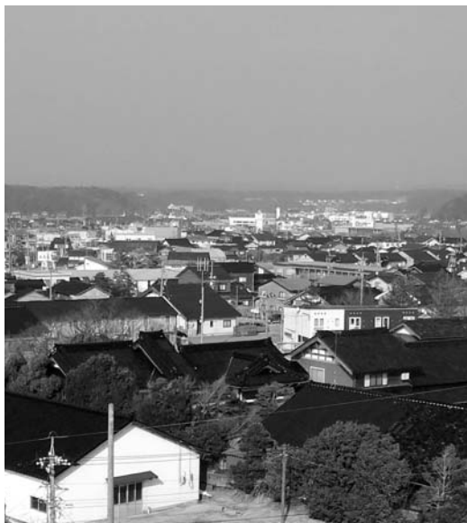
高浜町内でも空き家が多い
