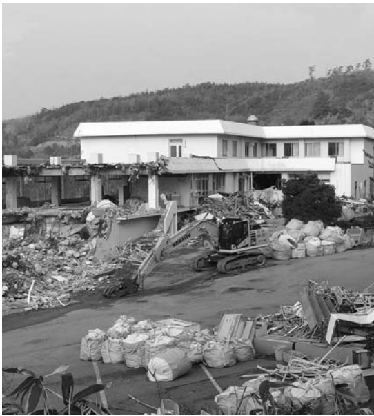
建物の撤去が進むレストラン巖門
