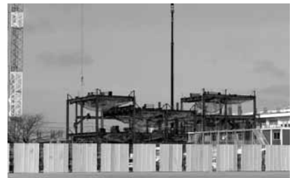
志賀小学校の校舎棟が立ち上がる
