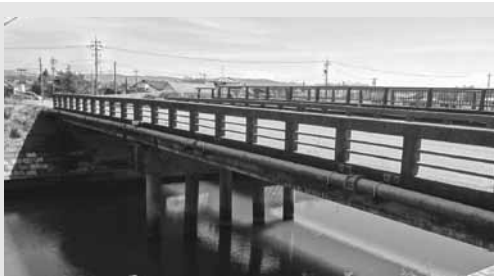
橋を点検し長寿命化を図る
