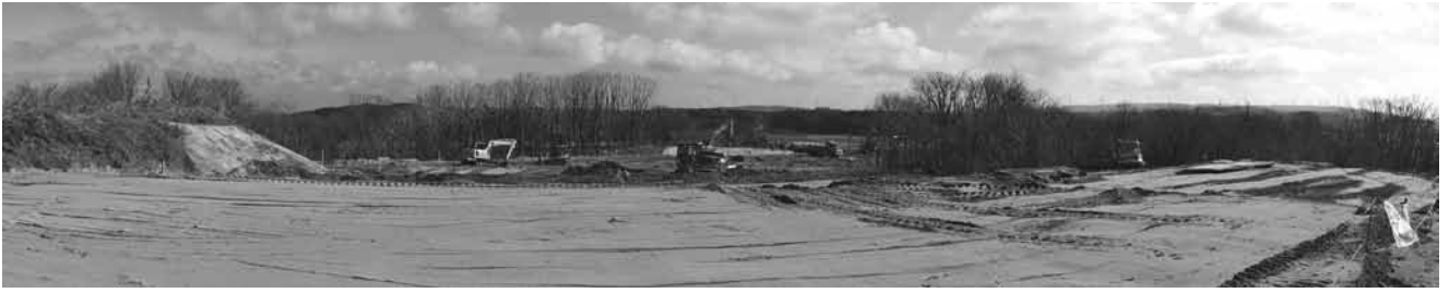
本格的な工事が始まった定住促進住宅地の造成
