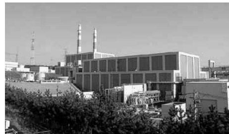
志賀原子力発電所
