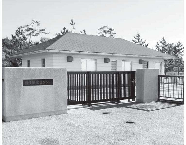
改修される赤住浄化センター
