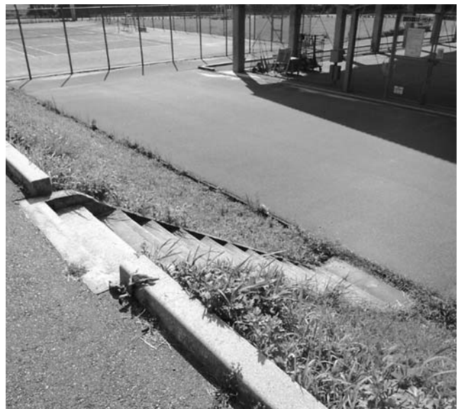
安全な階段に改修します
