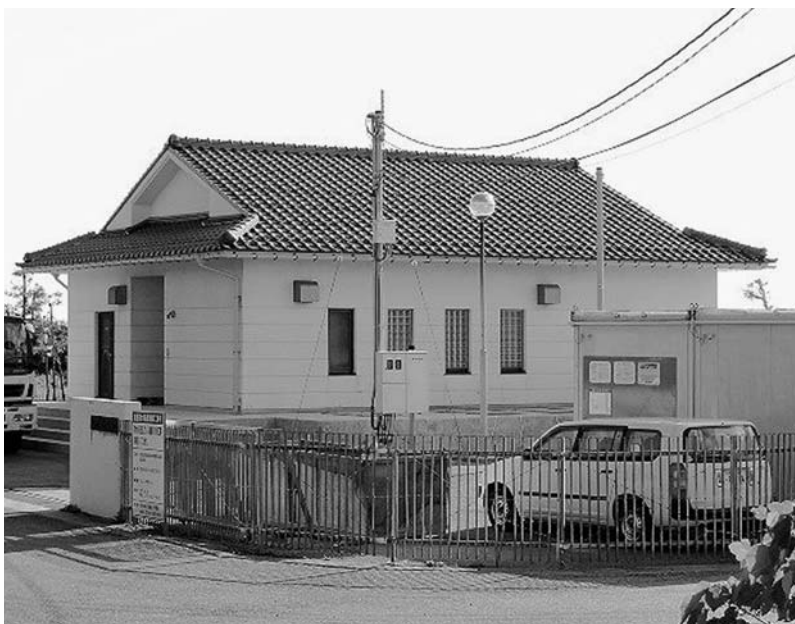
改修が進む上野浄化センター
