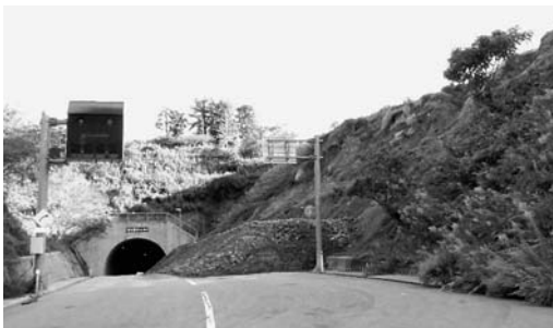
通行止めが続く羽咋市滝谷町の土砂崩れ
