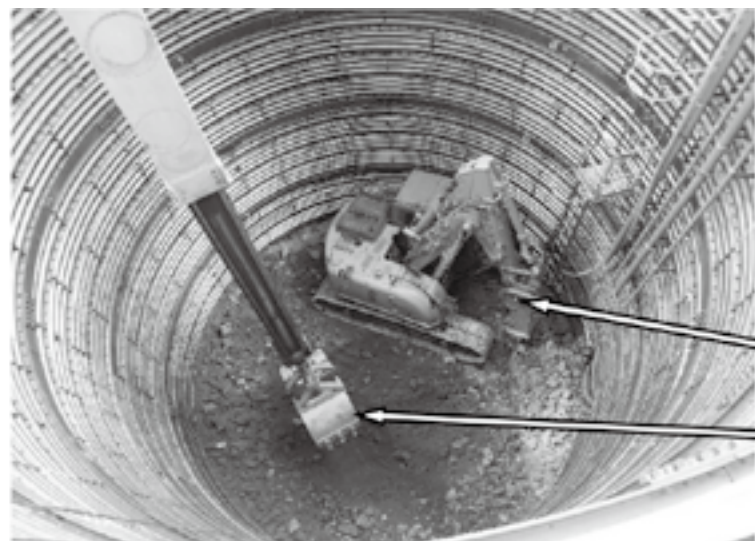
掘削作業の様子
