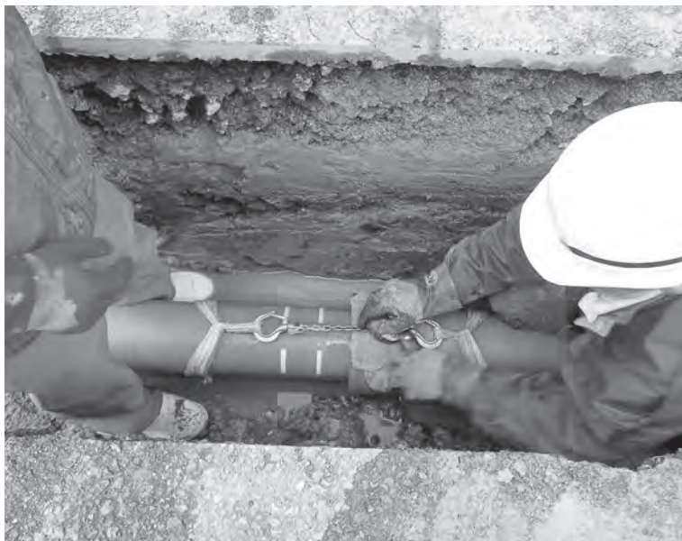
送水管の交換で水の安定供給を
