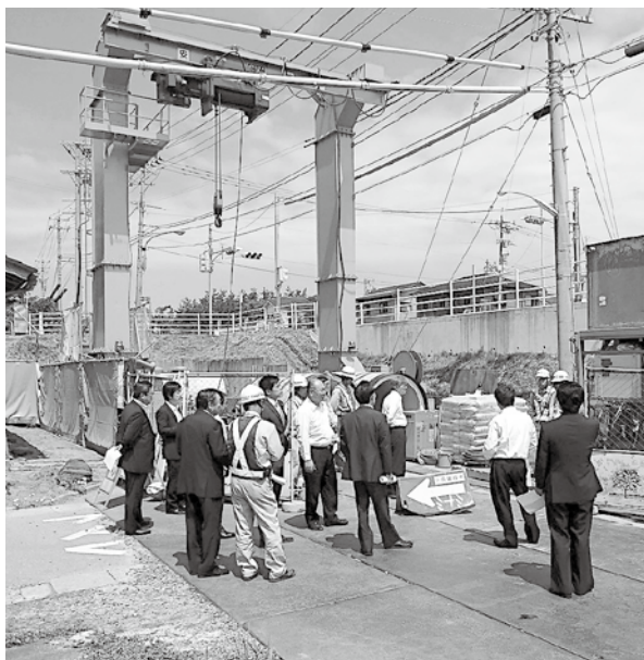
高浜地内の雨水管渠工事現場を視察
