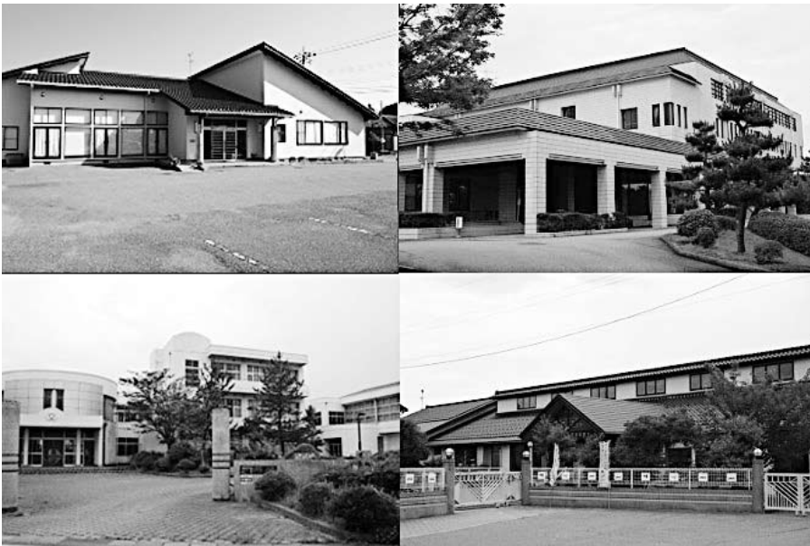
将来に向けたあり方が検討されている施設の一部
