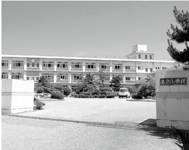
統合小学校の建設を予定する高浜小学校
