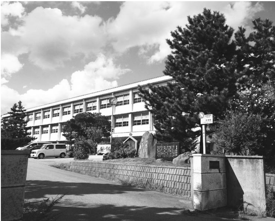
解体予算が計上された旧富来小学校
