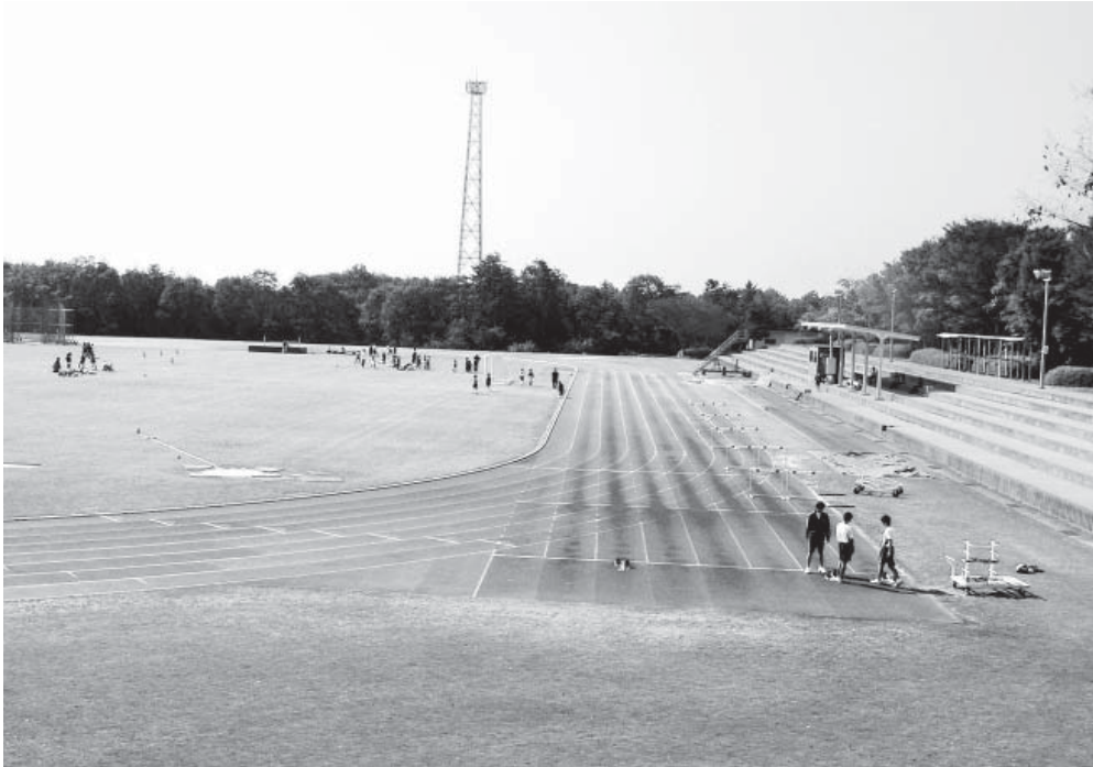
来年行われる石川県民大会の主会場となる陸上競技場の改修をします。トラック走路やスタートライン付近の改修、砲丸ピットの新設などを予定しています。
