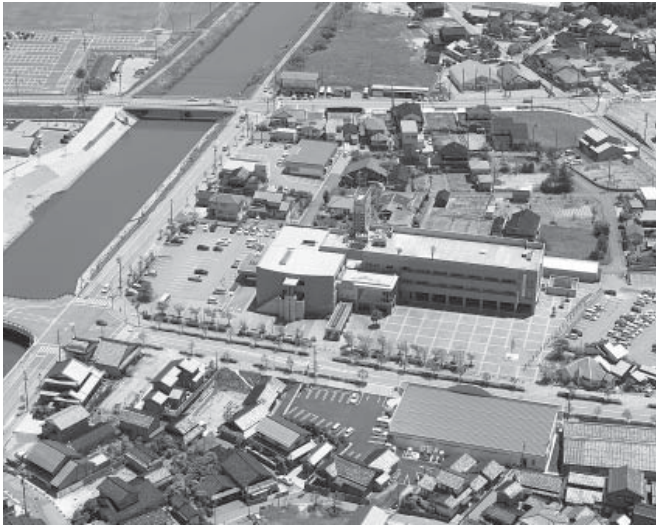
都市機能の充実と賑わいのある市街地の形成を目指している 賑わい創出重点地域(高浜地内：写真中央は町役場庁舎)
