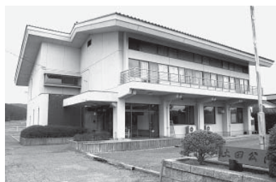
改修が予定される土田公民館
