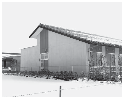
消防法の改正によりスプリンクラーの設置が必要となった町ショートステイ施設
