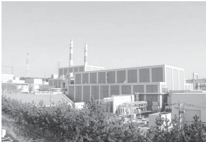
1号機が運転停止中の志賀原子力発電所
