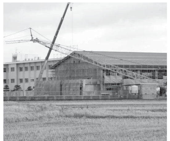
改築工事が進む富来小学校体育館
