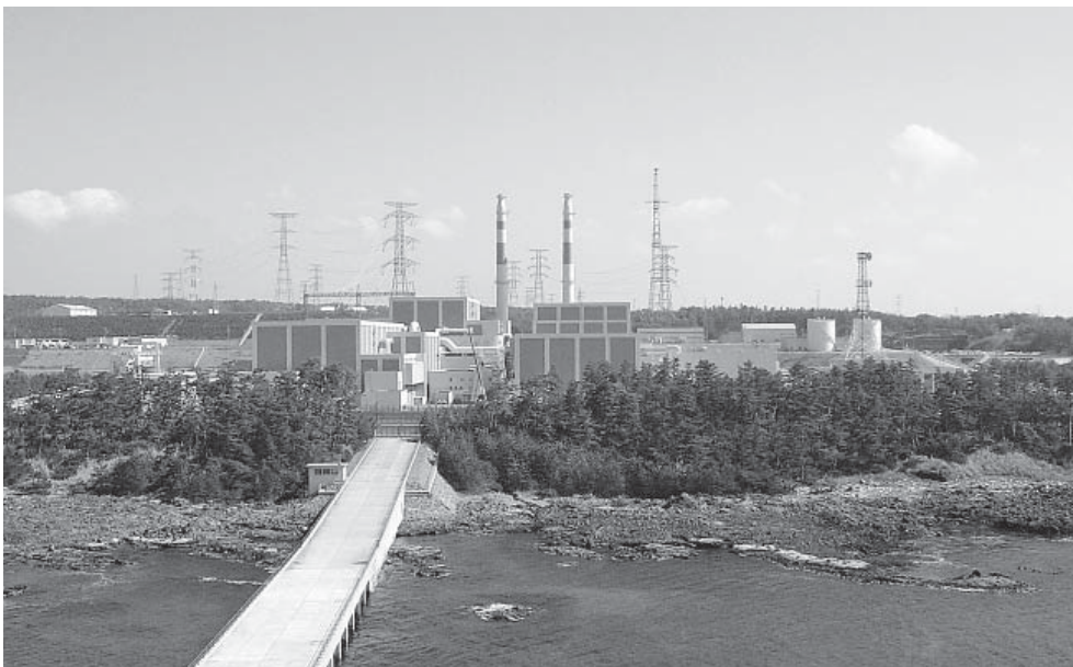
志賀原子力発電所全景
