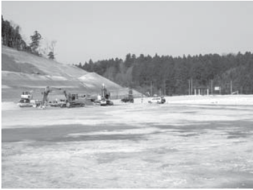
志賀消防署建設予定地
