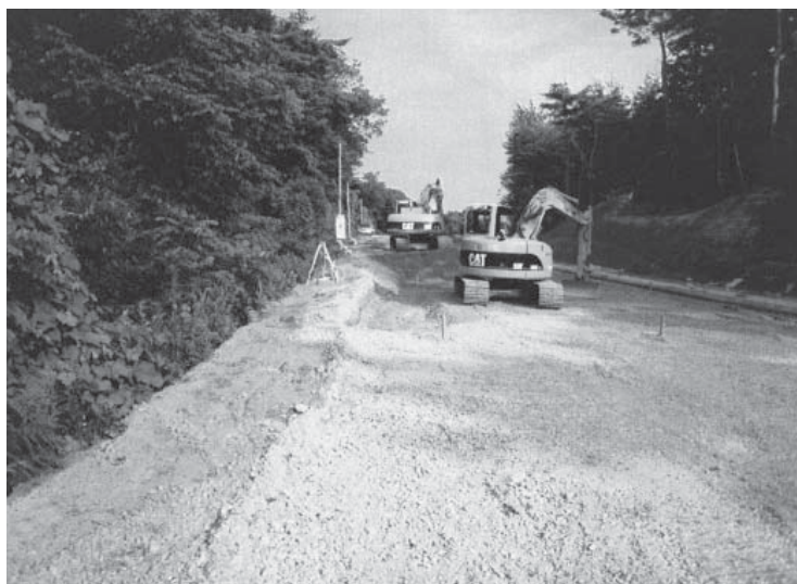
町道改良舗装事業で整備が進む町道(鹿頭酒見線)
