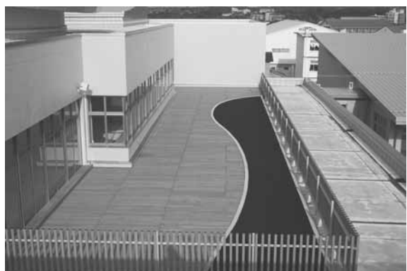
中央校舎の3階屋上 (ウッドデッキと植栽スペース)
