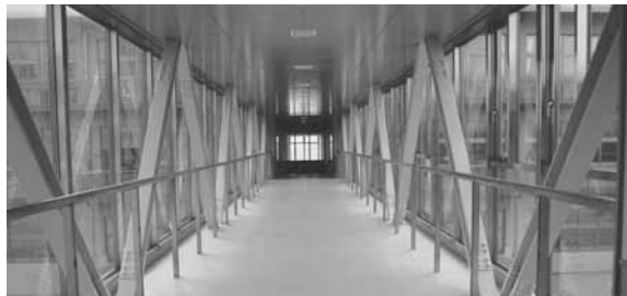
体育館2階より南校舎2階への渡り廊下
