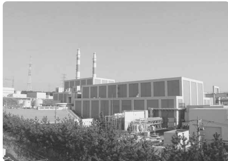
2号機の運転を停止している志賀原子力発電所
