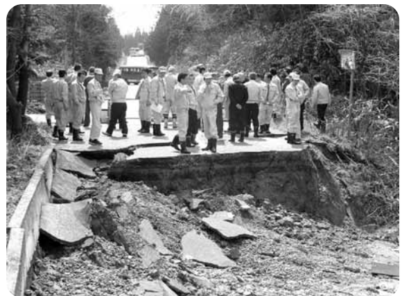
町道高浜羽咋線（宿女地内）の、のり面崩壊現場
