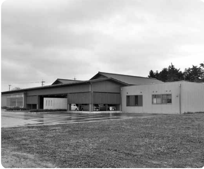
デイサービスに隣接して老人短期入所施設(ショートステイ)が整備され、平成20年の開所が予定されている。
