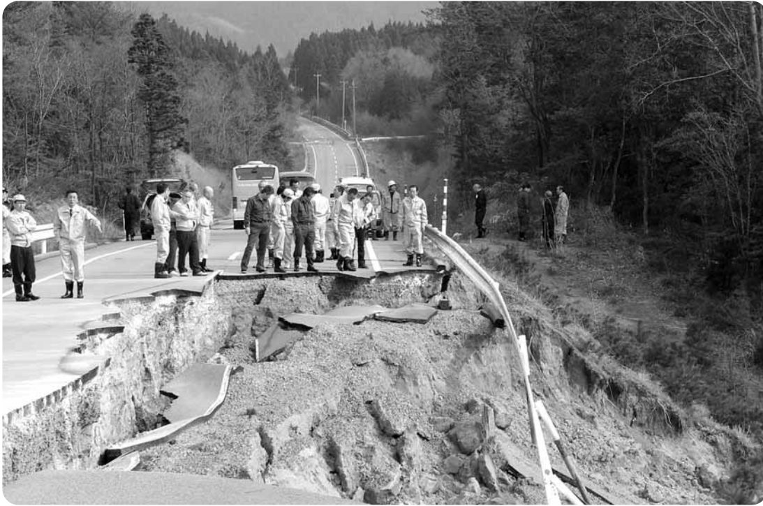
広域農道能登外浦地区（給分地内）で盛土崩壊の現場を視察する議員
