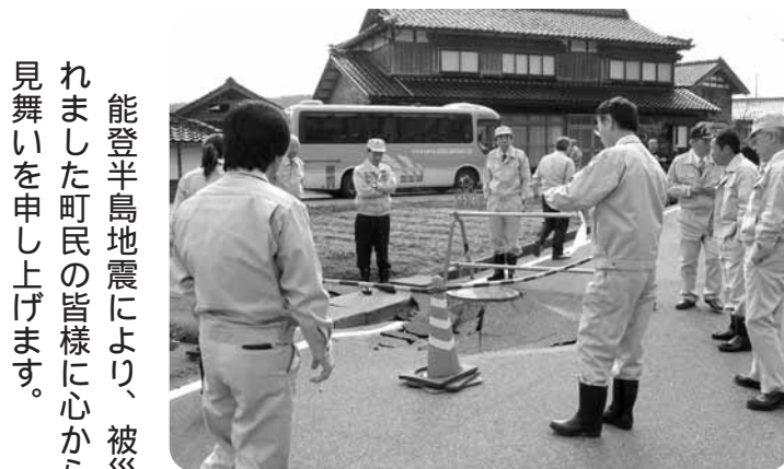
地震により農業集落排水のマンホールが隆起（豊後名地内）
