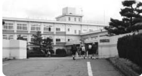
耐震工事を行う予定の高浜小学校
