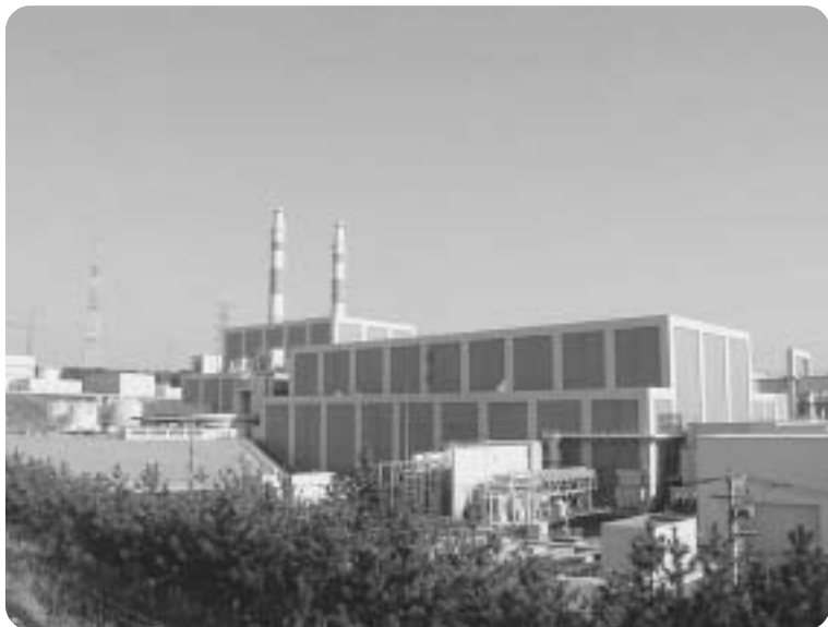
プルサーマル計画の導入が検討されている志賀原子力発電所
