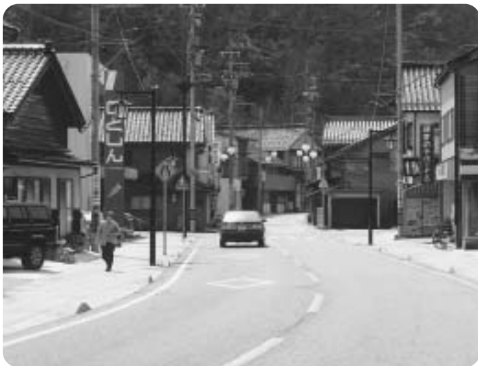
都市計画道路地頭町線（手前が整備済箇所）
