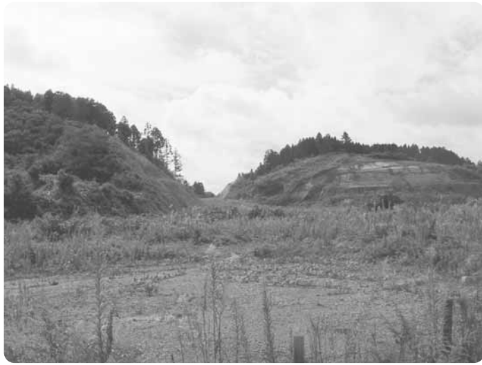
平成20年度に着手予定の定住促進住宅予定地(米浜地内)
