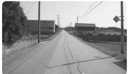
町道改良事業に追加となった鹿頭酒見線
