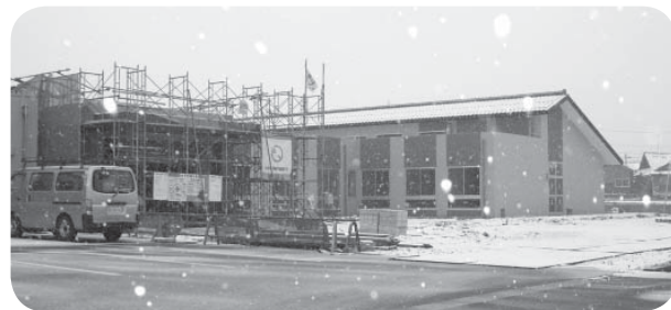
工事中のショートステイ施設
