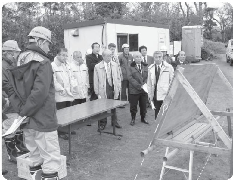
下水道工事の現場を現地視察する委員ら。(写真は長沢地内)
