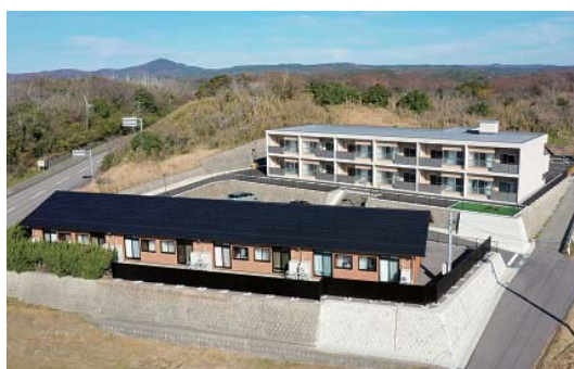
整備が完了した「ますほの丘住宅」
