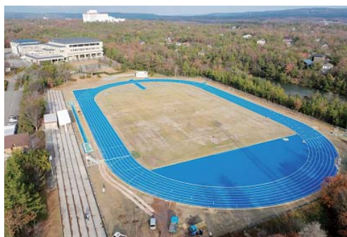
改修工事が進められる町陸上競技場
