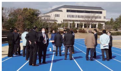
改修工事が完了した陸上競技場
