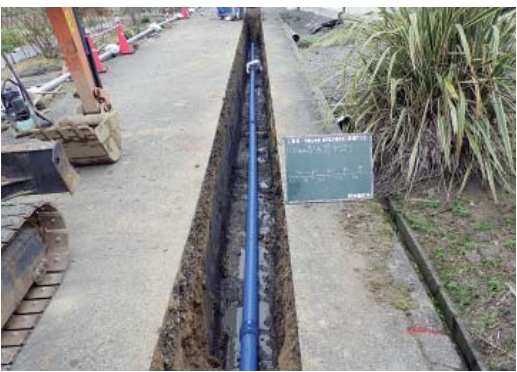
毎年増える水道更新工事
