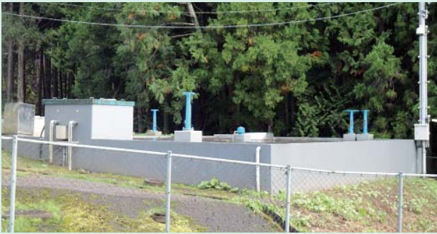
耐震化工事が施された広地配水池
