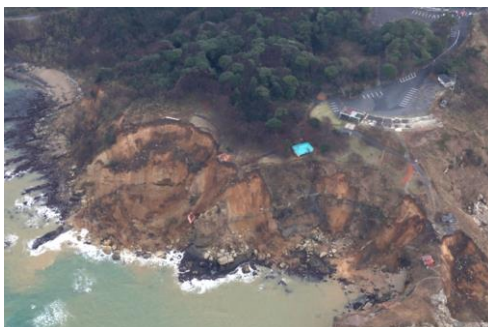
能登金剛の北側の大規模崩落
