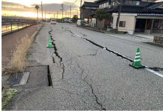
於古川護岸の被災状況
