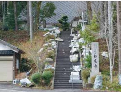
▲倒壊した松尾寺の石灯籠
