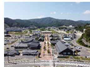
道の駅おながわ (宮城県女川町)
