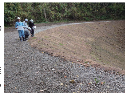
復旧工事を実施した農道
