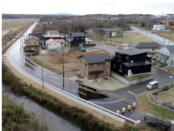
町道改良工事
