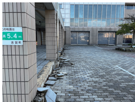
庁舎改修事業
