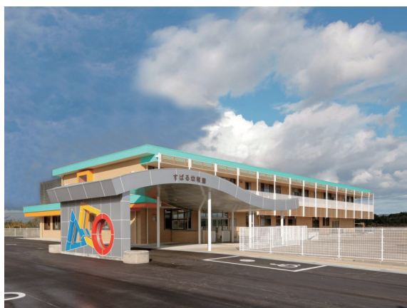
保育施設の整備
