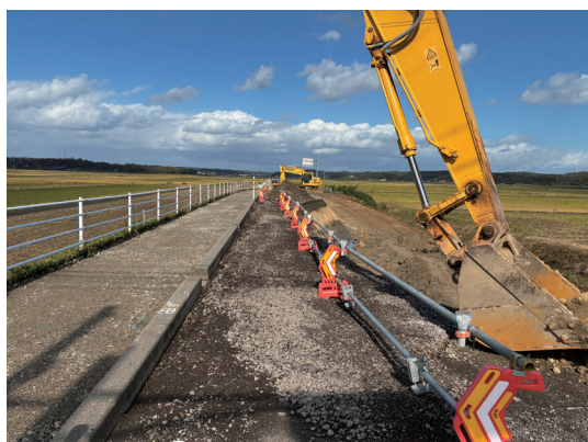
町道第740号西山羽咋線災害復旧工事
