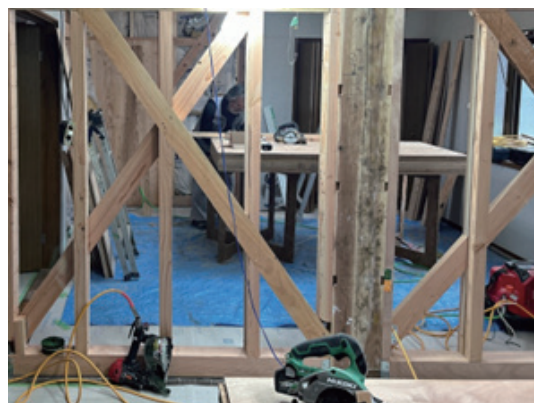
住宅の耐震化工事
