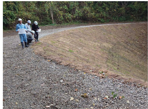
復旧工事を実施した農道
