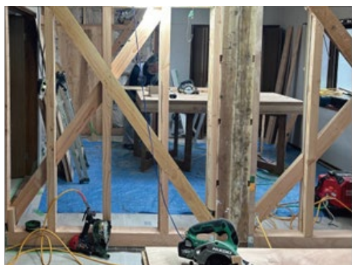
住宅の耐震化工事
