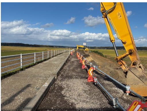
町道第740号西山羽咋線災害復旧工事
